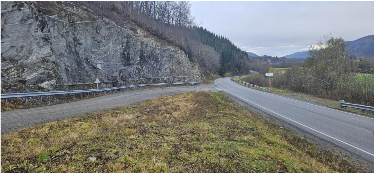
Figur 15 Avkjørselen fra Fv65 mot Surna trafostasjon. Foto Sweco 15.10.2024
