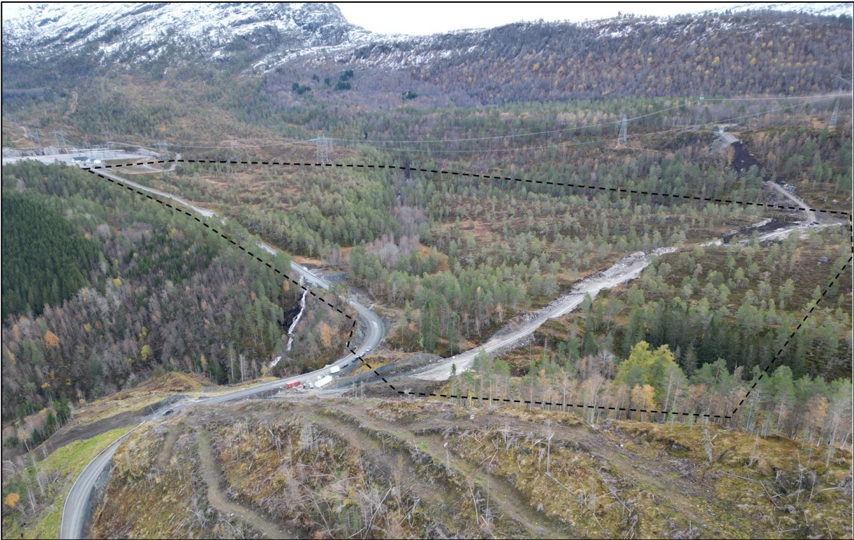
Figur 1 Dronefoto tatt 15.10.2024 fra nordvest, med omtrentlig påtegnet plangrense. Trafotomt sees bakerst til venstre i bilde. Rørtraseen til Sætergrytå kraftverk sees til høyre i bilde.
