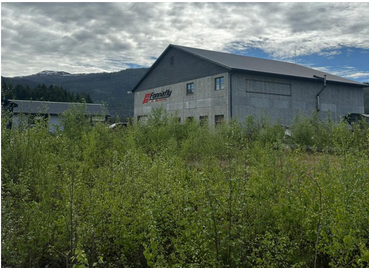
Figur 6-1 Bygningsstrukturar i planområdet
