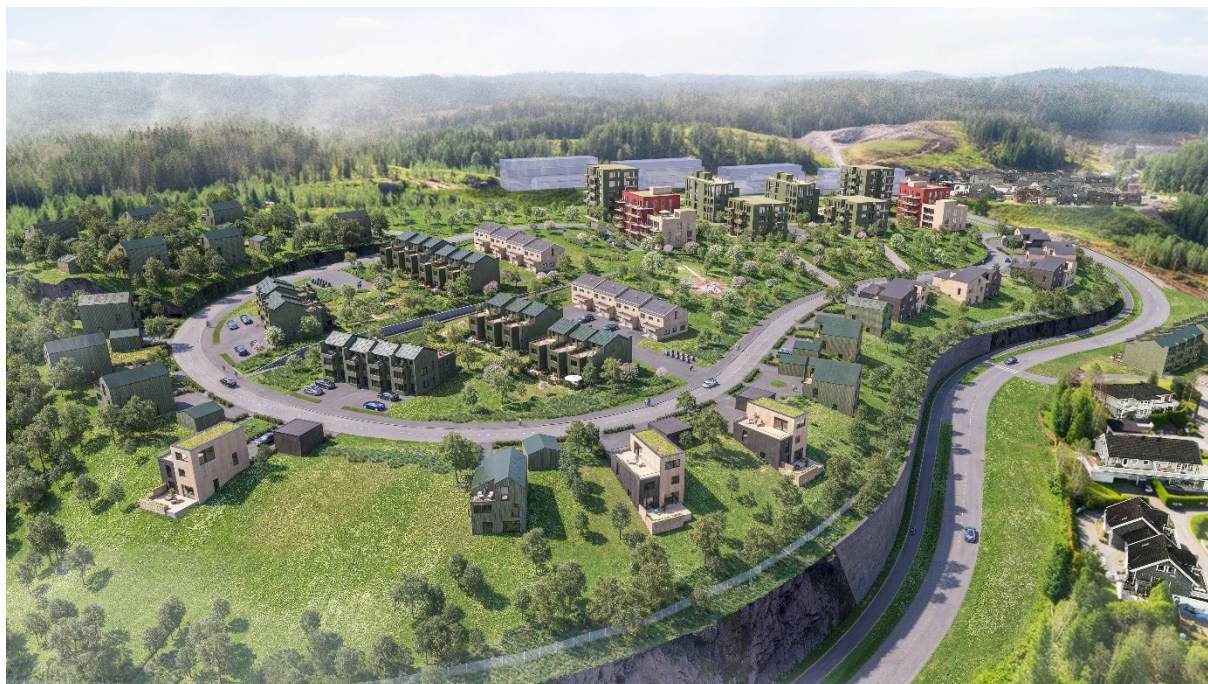
Visualisering viser oversikt over tenkt ny bebyggelse på tomten, sett fra sør.
