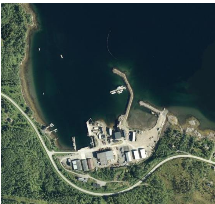
Figur 4-4. Figuren viser bølgedempere i Hellarbogen. Kilde: norgebilder.no
