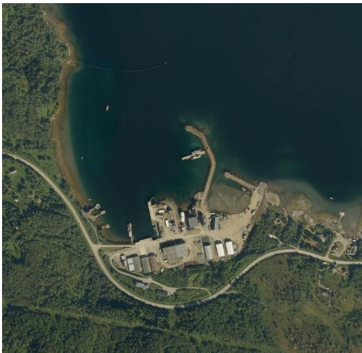
Figur 4-3 Figuren viser bølgedempere i Hellarbogen. Kilde: norgebilder.no
