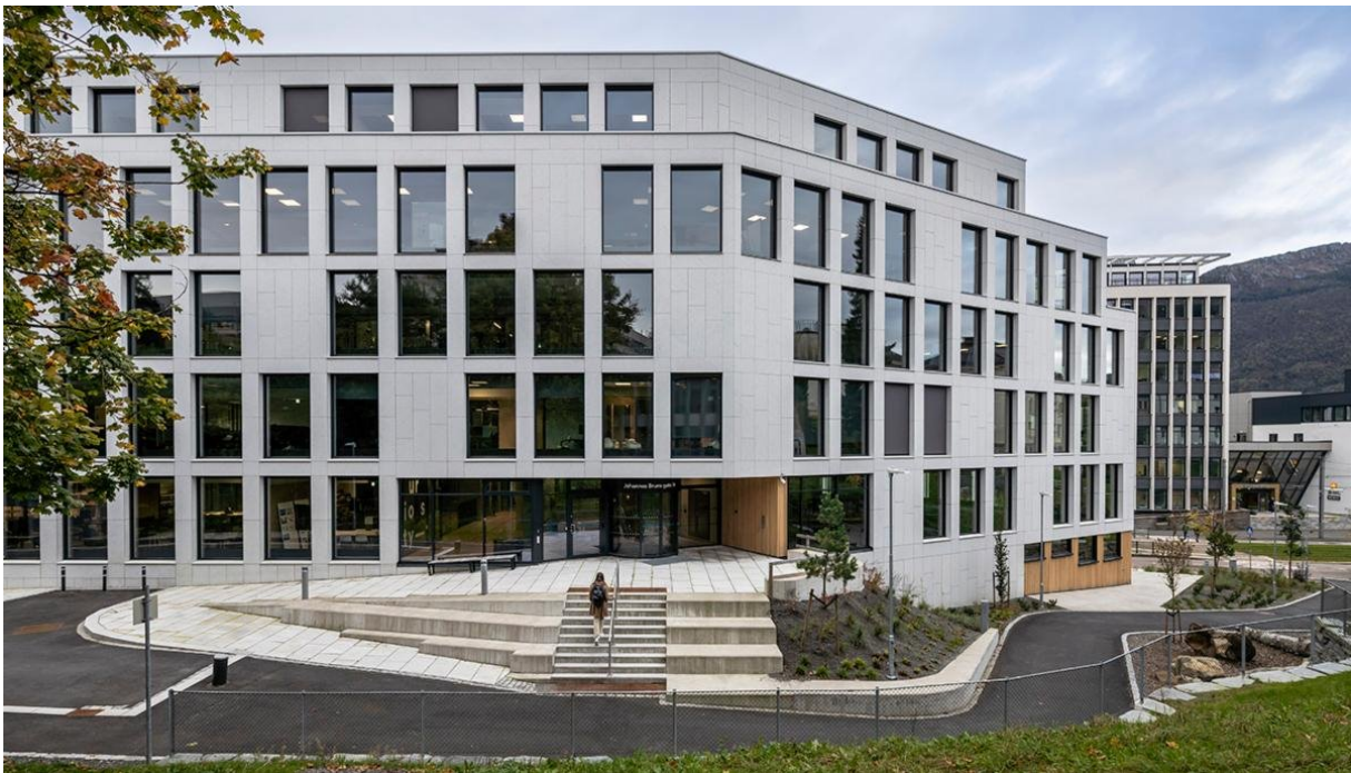
Gangforbindelser har potensial til å kunne tilføre kvaliteter og å kunne fungere som uteoppholdsareal og byrom.
