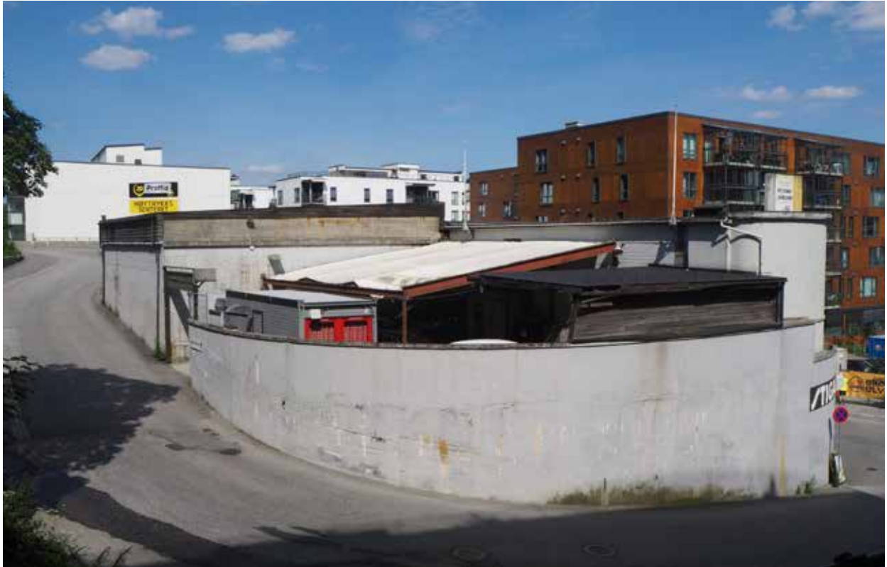
Dagens situasjon, fasade ut mot Lothevegen. Her ser ein avrundinga ut mot vegen og muren framfor der oljetankane opphavleg stod. Ut frå Byggesaksarkivet har det ikkje vore mogleg å finne ut når tankane vart fjerna. Dei vart fjerna etter 1978 ein gong.
