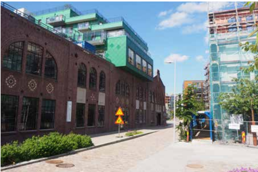
Den gamle fabrikkbygningen til Bergen Blikktrykkeri med adresse, Damsgårdsveien 62, har nylig gjennomgått ein stor transformasjon. Fasaden ut mot Damsgårdsveien er bevart og integrert i eit større anlegg med over 100 leilegheiter, barnehage og daglegvarebutikk. Til høgre i bildet ser ein den gamle fabrikk til Kavli (Damsgårdsveien 59). Bildet er tatt like aust for planområdet.
