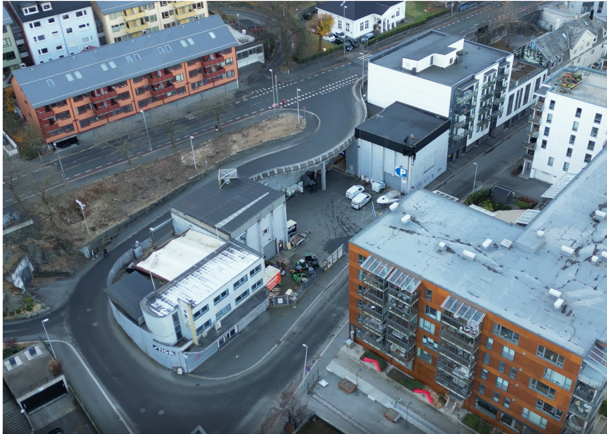
DAMSGÅRDSVEIEN 70. EKSISTERENDE BEBYGGELSE
