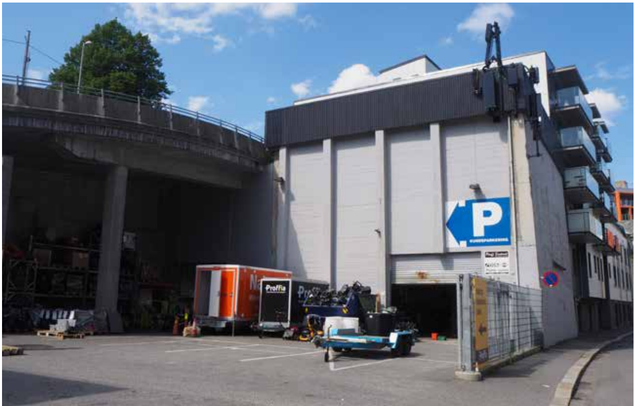
Dagens situasjon – planområdet med bygg og område der det før var oppbevaring av koks/kull. Sett fra Damsgårdsveien, bildet er tatt fra søraust.
