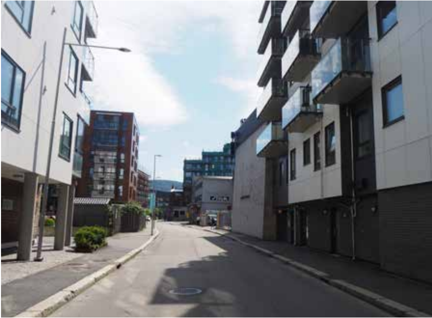
Damsgårdsveien, like nordvest for planområdet. I midten ser ein Damsgårdsveien 70.
