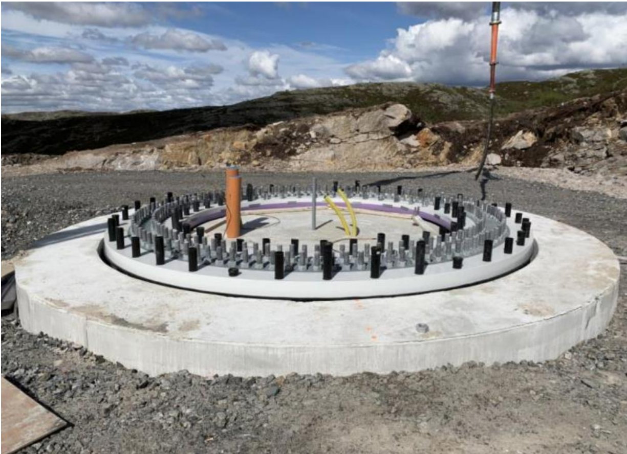
Figur 8: Eksempel på fjellfundament. Kjelde: Multiconsult
