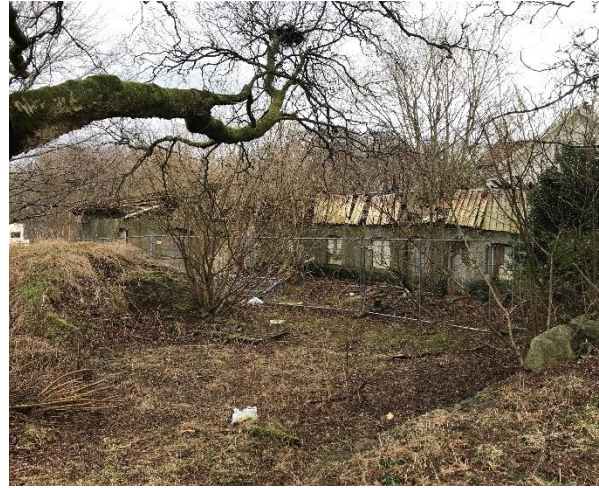
Figur 3 Restene etter driftsbygningen som er sperret av med gjerde.
